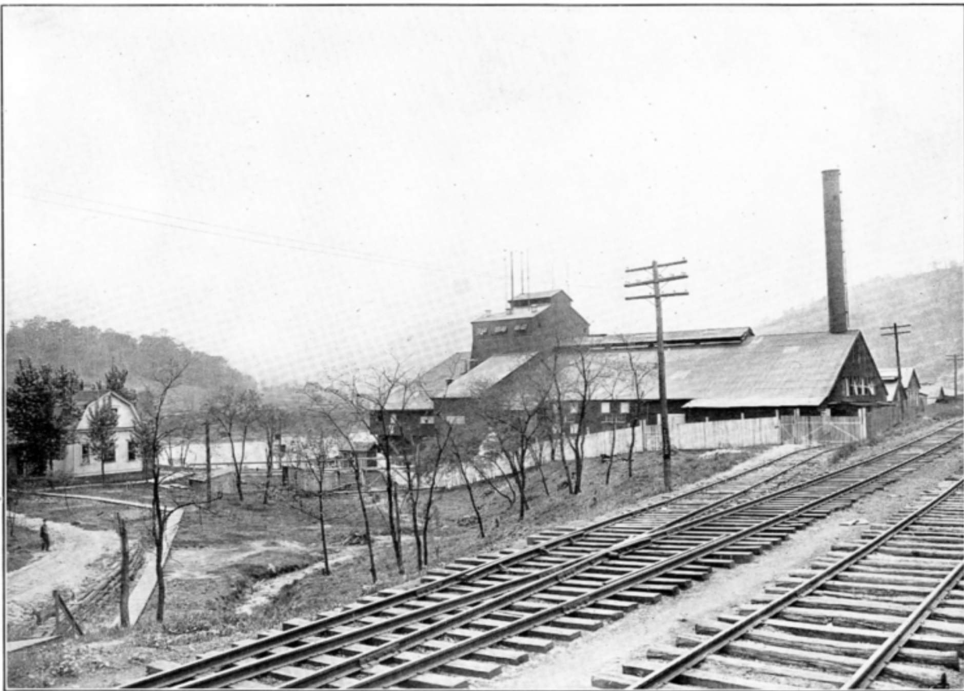
U. S. WINDOW GLASS PLANT
